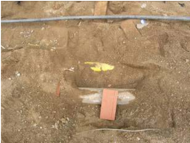
Foto 2: Rasa de l'Avinguda Cambó: Detall dels serveis.
