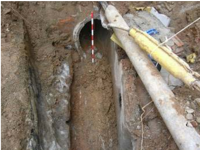
Foto 4: Segona intervenció a l'Avinguda Cambó, detall del col·lector.
