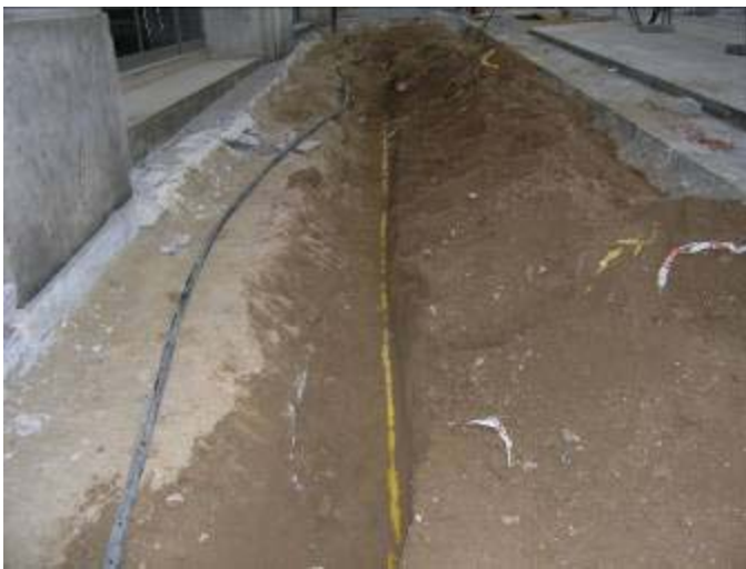
Foto 1: Rasa de l'Avinguda Cambó: fotografia final.
