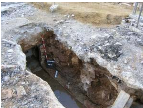
Foto 6: Primera intervenció al c/Mercaders, vista general de la rasa.
